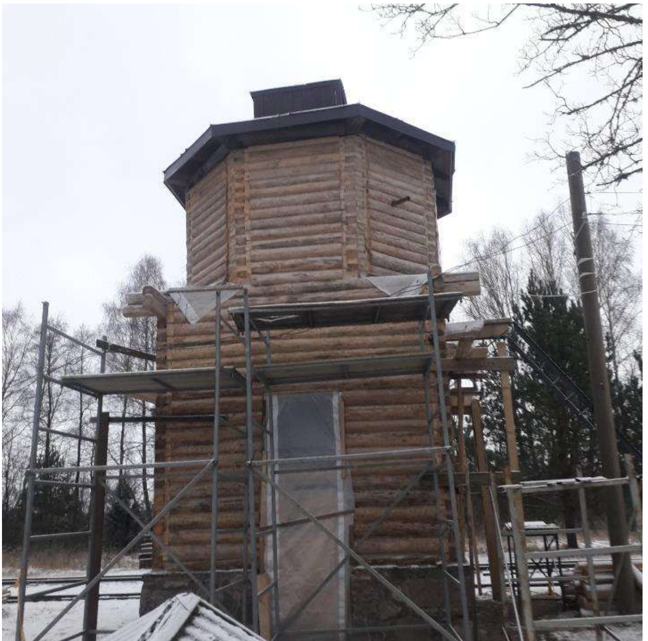
1 pav. Esamo vandentiekio bokšto būklė
